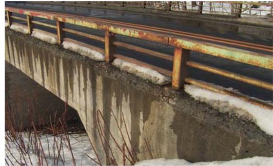
写真-2 凍害・塩害複合劣化による橋梁地覆コンクリートのスケーリング
