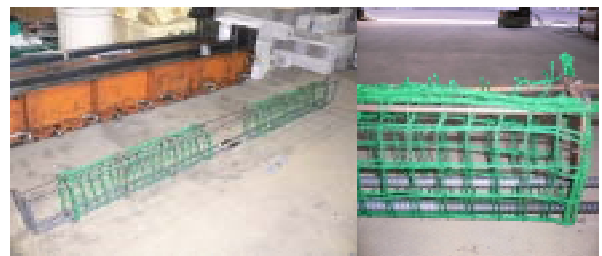
写真 - 2 化学ネット 2 重の配置状況
