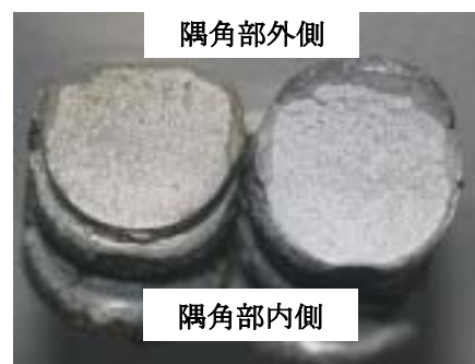
写真－6 鉄筋破断面
