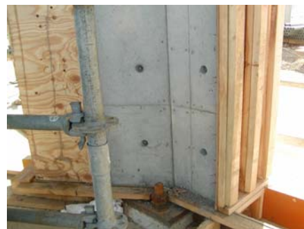
写真-3 叩きのみで締め固めた柱脚部
