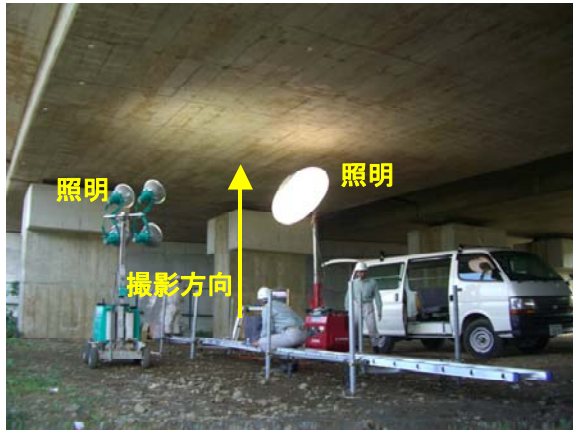
写真-2 ひび割れ画像撮影状況（全景）
