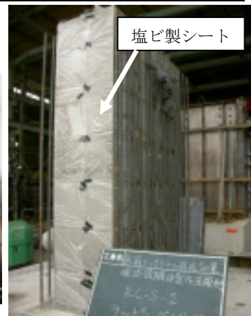
写真—3 補強部施工前状況(RC-S-2)
