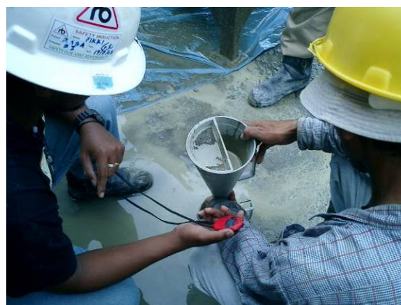
写真-2 MCV 測定状況
