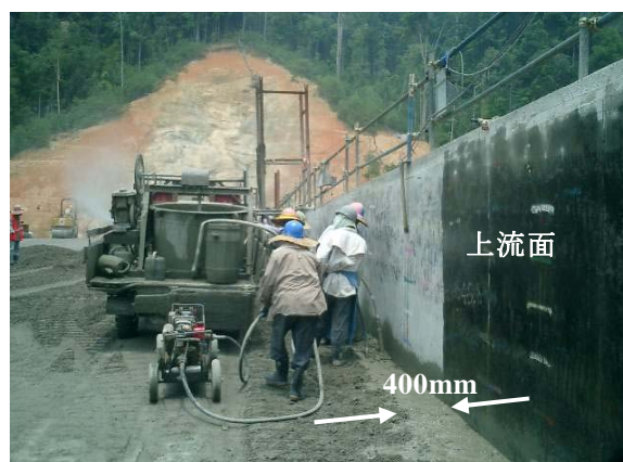
写真-4 アジテータ搭載トラックによる運搬
