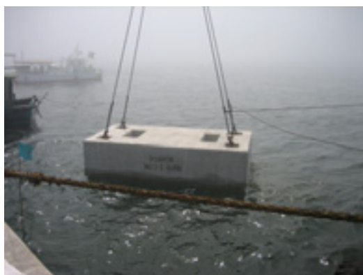
写真-3 海中沈設状況
