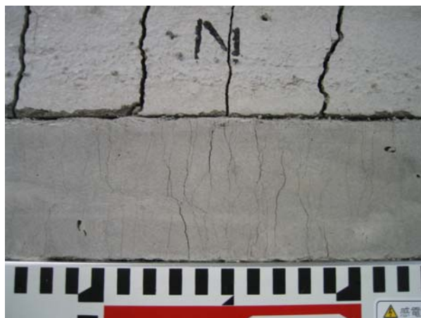
写真-1 両引試験供試体に発生したひび割れ状況の例 (写真上: N45, 写真下: H45)
