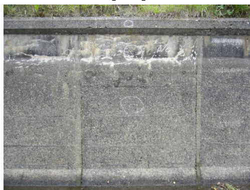
写真-2 測定箇所
