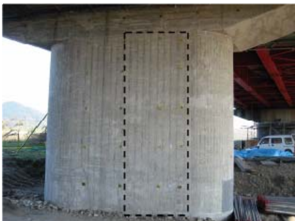
写真-1 橋脚Aの概観
