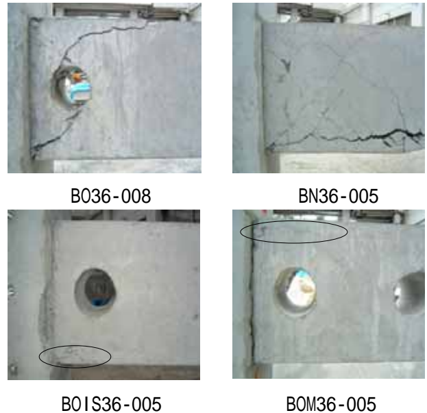
写真 1 ひび割れ状況 (実験終了時)
