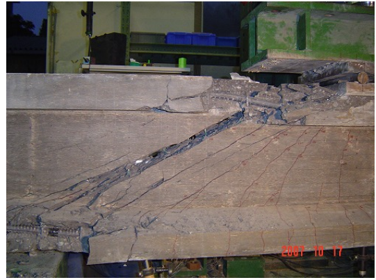
写真-2 UHIPRC-1破壊状況
