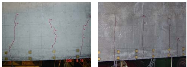
(a) 普通コンクリート (b) 高強度コンクリート
