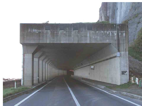
写真-1 落石防護覆道の一例
