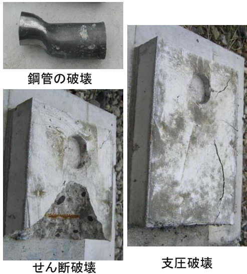
写真-2 要素試験体の破壊状況
