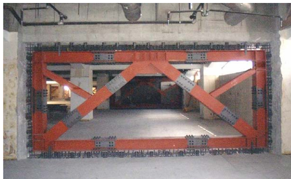
写真-1 鋼管コッターの施工状況
