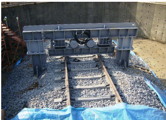
写真-1 耐久試験状況
