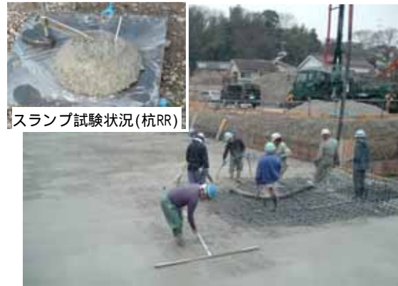
写真 - 1 耐圧盤の打設状況
