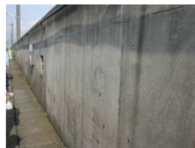
写真-1 場所打ちコンクリート製防音壁の外観
