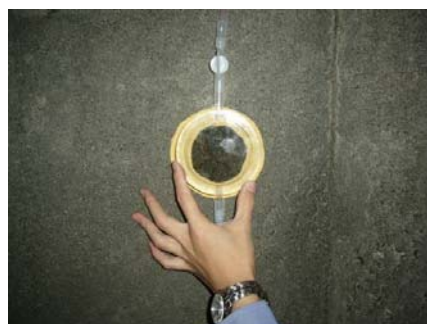
写真-7 現位置における吸水性試験器具の設置状況
