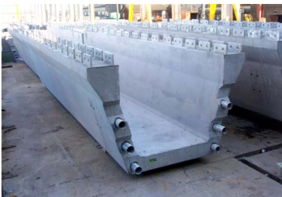
写真-1 UFCプレキャスト桁
