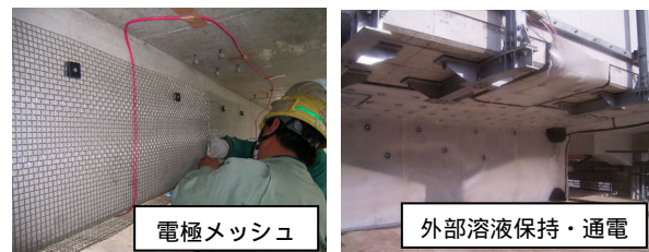
写真-2 コンクリート構造物への試験施工
