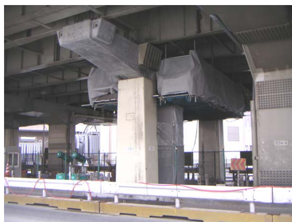
写真-7 環 1034 橋脚再構築後全景
