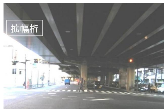
写真-5 環 1039 橋脚全景
