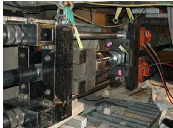
写真-6 引寄せジャッキ
