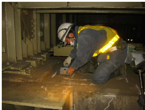
写真-3 鉄筋探査状況
