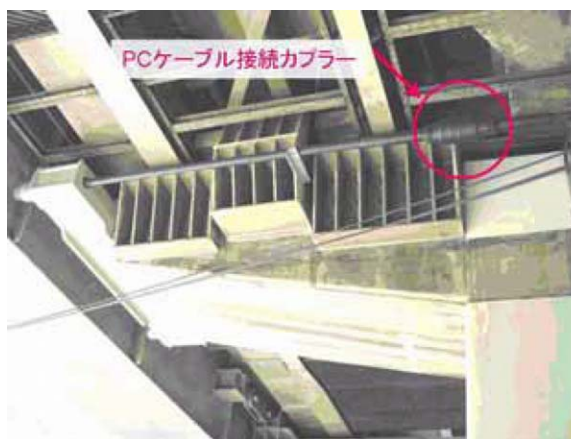
写真-8 環 1039 橋脚外ケーブル定着部
