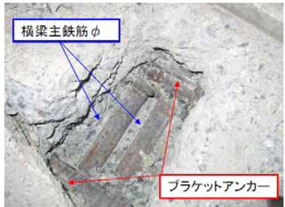
写真-2 主鉄筋切断状況
