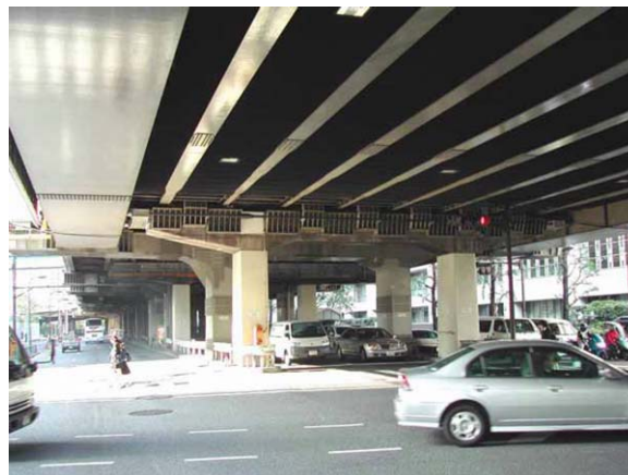
写真-9 環 1039 橋脚外ケーブル補強後全景
