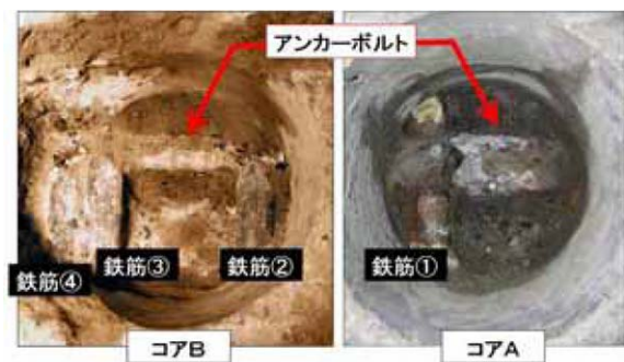
写真-4 主鉄筋干渉状況
