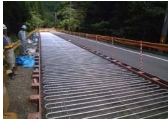
写真-1 パイプヒーティングパネル設置状況
