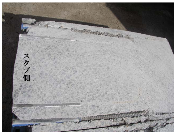
写真-2 コア部分の破壊状況 (H1)
