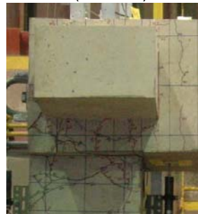
写真-6 FL-6 破壊状況 (R=±1/25)
