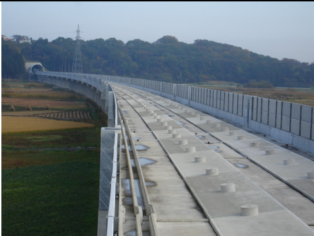
写真-1 線区Aの俯瞰状況
