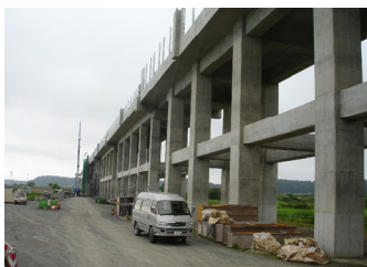
写真-2 B-第1高架橋R2(2層式)
