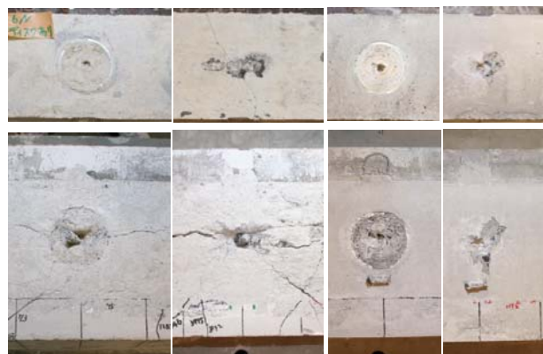
写真-5 接合面の破壊状況 (シリーズ I)
