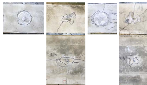
2D06 2N06 2D16 2N16 写真-9 接合面の破壊状況 (シリーズ II)
