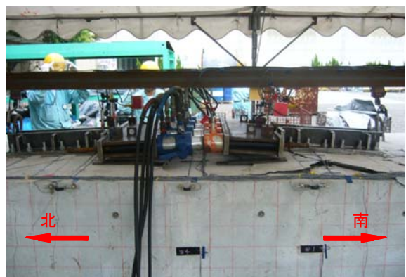
写真-2 ブラケット近傍の最終損傷状況
