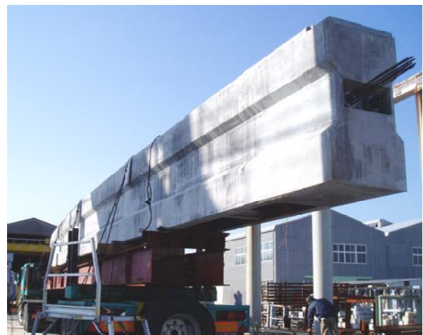
写真-1 モノレール曲線桁の完成（搬出時）
