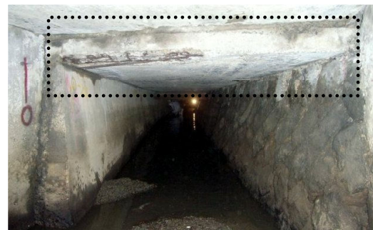
写真-1 補強対象水路
