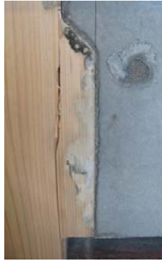
写真-3 破壊性状 (Aa-1-h210t30 左側シアキー外集成材余長部せん断破壊)
