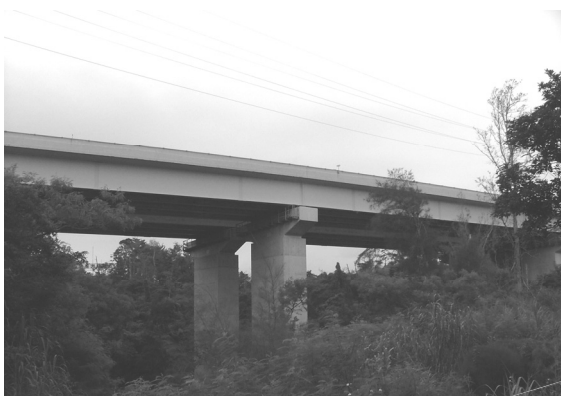
写真-1 徳首川橋外観
