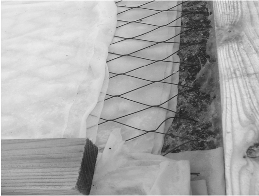
写真-4 外部電極の状況
