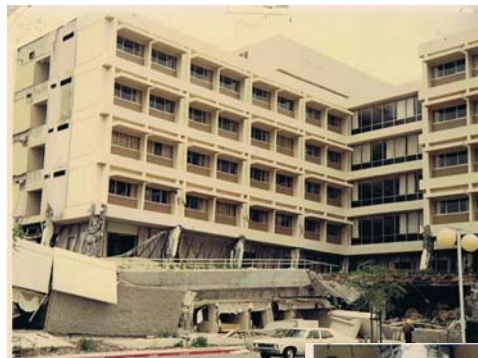
写真-1.1 1971年のオリビュー病院の被害状況と1階ピロティのConf.柱の大残留変位(残留変位約50cm, 変位角約1/5)(文献1-1)
