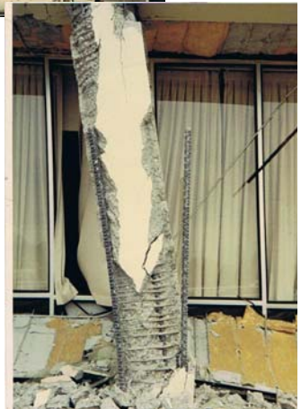
写真-1.1 1971年のオリビュー病院の被害状況と1階ピロティのConf.柱の大残留変位(残留変位約50cm, 変位角約1/5)(文献1-1)
