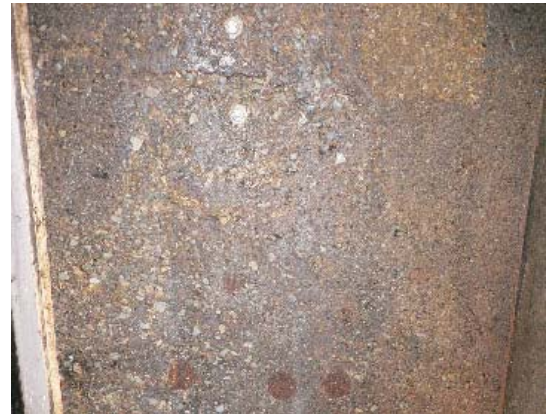
(b) 活性炭吸着槽
