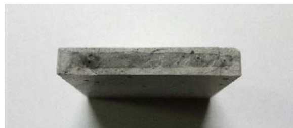
写真-2 曝露45日のセメントペーストの劣化部
