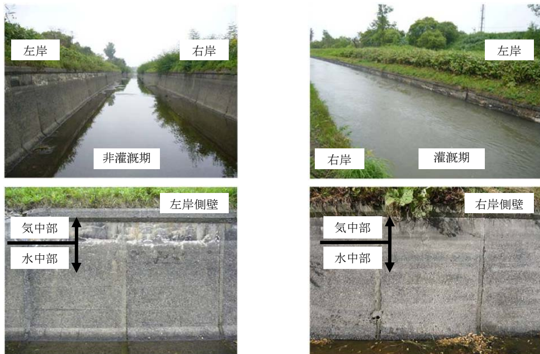
写真-2 開水路の状況
