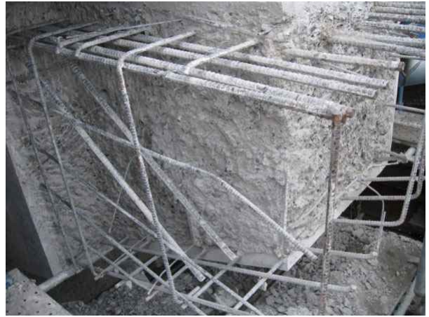
(b) 橋脚・はり (D橋)
