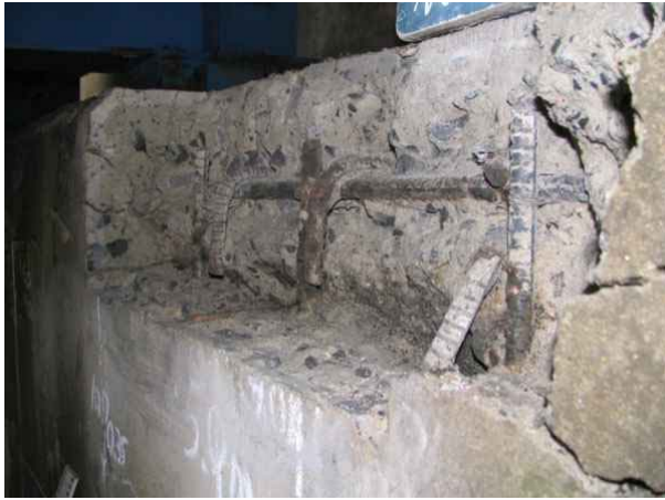
(a) 橋台・橋座 (D橋)
