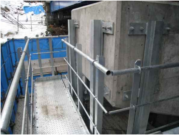
写真-5 橋脚・はりの検査路
