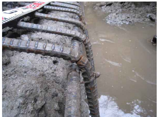
(d) 橋脚・フーチング (I橋)
