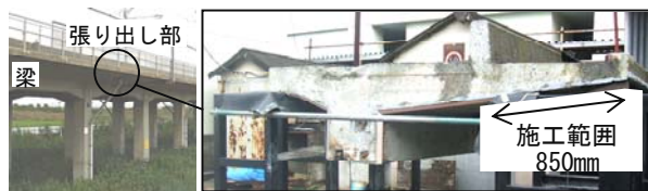
写真-1 注入試験の対象
