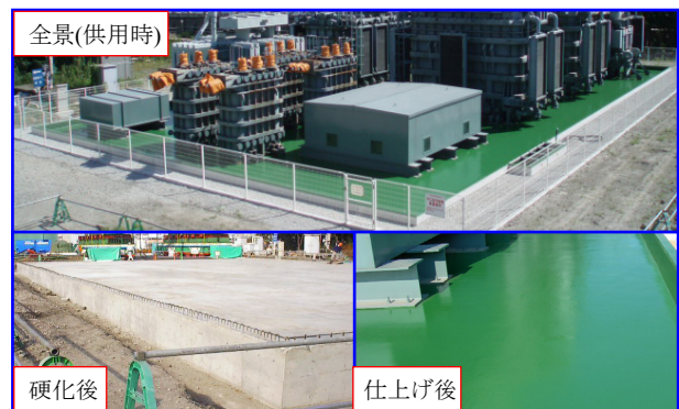
写真-1 実構造物の外観
