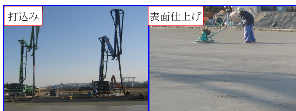
写真-2 実構造物の施工状況
