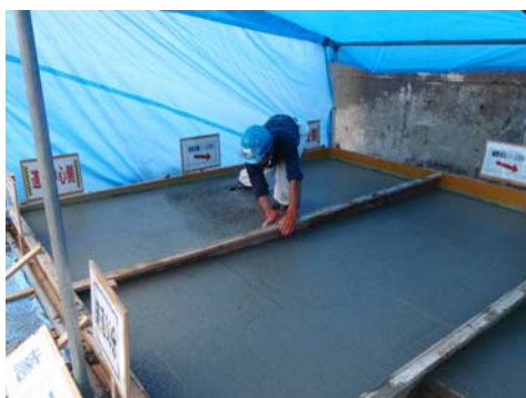
写真-3 締固め状況
