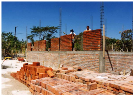
写真-1 建設中の枠組組積造建物
