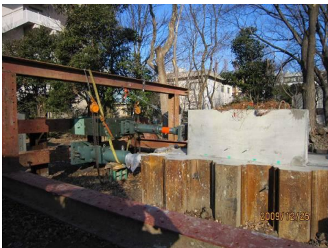
写真 - 1 仮動的実験荷手状況 (B 橋)
