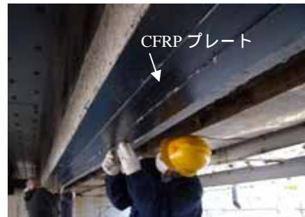
写真 - 1 CFRP プレートによる曲げ補強事例
