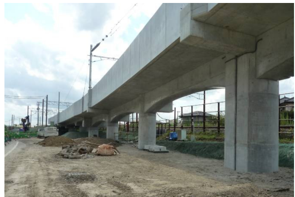
図 - 2 高架橋周辺状況
