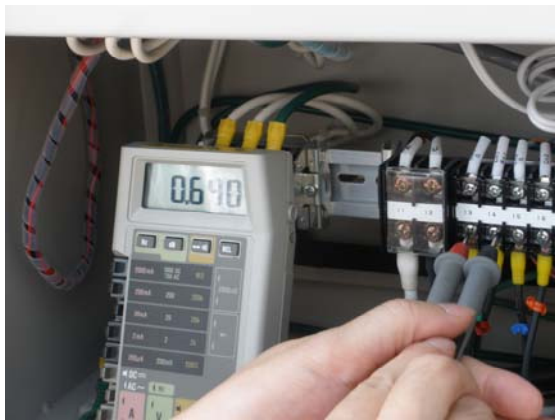
写真-4 現地計測状況 (直流電圧計使用)
