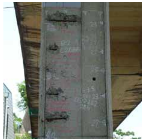
写真 - 4 柱 (C 高架橋)
