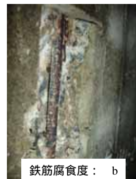
写真 - 5 ひび割れ箇所での鉄筋はつり出し
