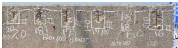
写真-1 高欄上部(A及びB高架橋)
