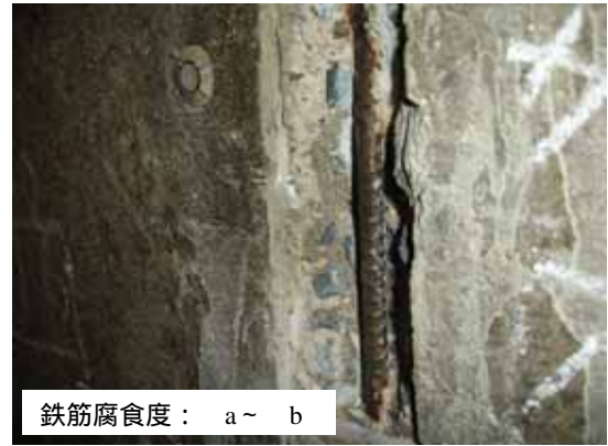
写真 - 7 剥離箇所での鉄筋はつり出し
