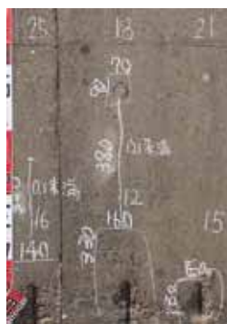
写真-2 高欄下部 (A及びB高架橋)
