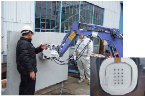
写真-8 壁面はつりを対象としたプロトタイプ機の状況
