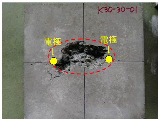
写真-1 高電圧パルス放電はつり工法によるコンクリートのはつり状況
