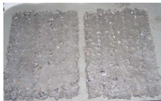
写真-7 性能確認試験後のコンクリートの状況（下向きはつり）
