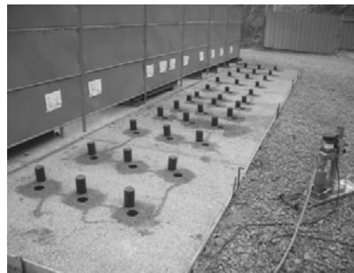
(a) POC 舗装とコア抜き状況
