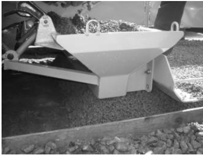
写真-3 敷均しの様子
