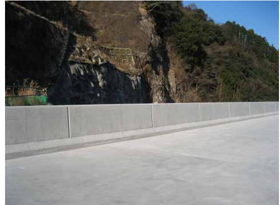
写真-2 現場施工壁高欄脱型直後
