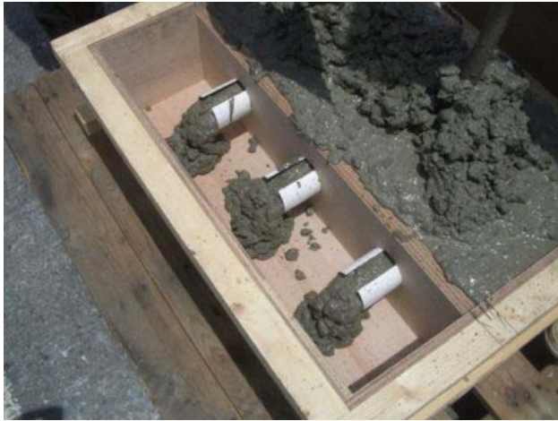
写真 - 2 打設時の状況
