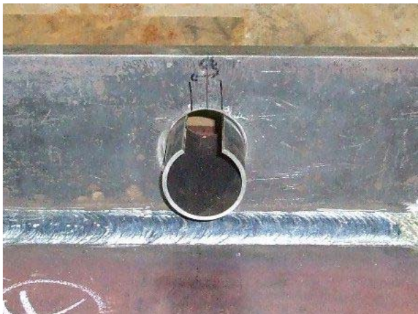
写真-1 新型ジベル挿入状況
