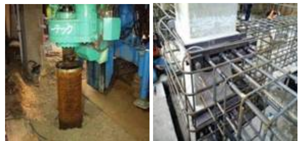
(鋼管杭圧入) (地中横梁と柱周り鉄筋組)
