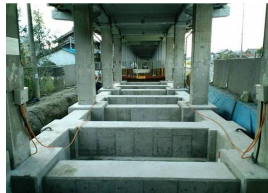
写真-3 地中梁完成時の状況
